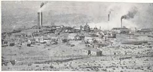
El Paso Smelter
